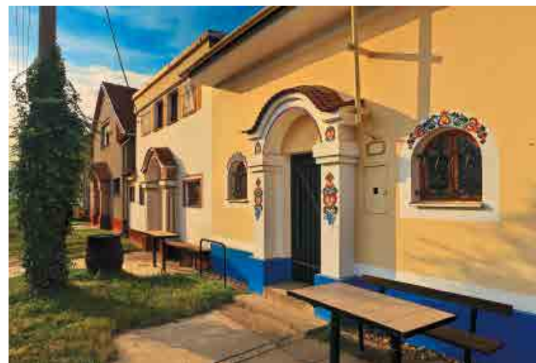
Podobných sklepů je v Mutěnicích téměř pět set
